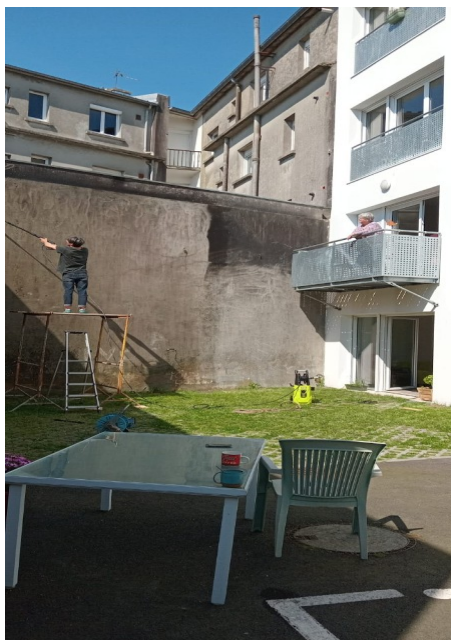
Chantier participatif dans la cour
